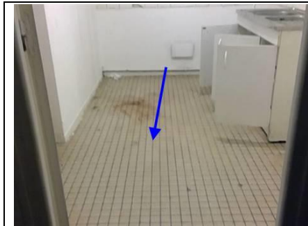
Photo n° PhA001 Localisation : Cuisine; WC; Salle de bains Ouvrage : 5 - Planchers et planchers techniques - Revêtements de sols Partie d'ouvrage : Colle de carrelage Description : Colle de carrelage
