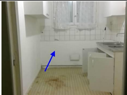
Photo n° PhA002 Localisation : Cuisine; Salle de bains Ouvrage : 3 - Parois verticales intérieures - Murs et cloisons maçonnés Partie d'ouvrage : Enduit à base de plâtre lissé ou taloché Description : Enduit à base de plâtre lissé ou taloché
