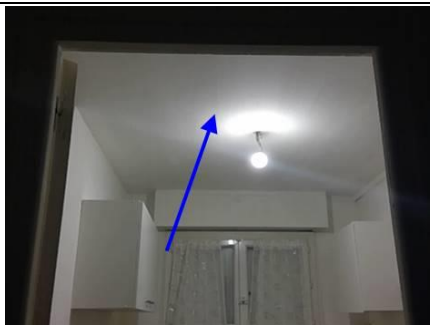
Photo n° PhA005 Localisation : Cuisine; WC; Salle de bains; Buanderie Ouvrage : 4 - Plafonds et faux plafonds - Plafonds Partie d'ouvrage : Enduit à base de plâtre lissé ou taloché Description : Enduit à base de plâtre lissé ou taloché
