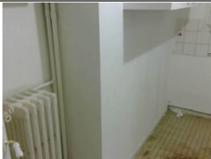
Photo n° PhA003 Localisation : Cuisine; Salle de bains Ouvrage : 3 - Parois verticales intérieures - Murs et cloisons maçonnés Partie d'ouvrage : Enduit à base de plâtre lissé ou taloché Description : Enduit à base de plâtre lissé ou taloché
